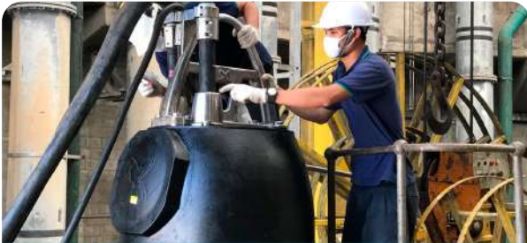
การบำรุงรักษาเครื่องสูบน้ำแบบ Submersible
