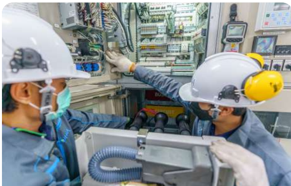
การตรวจสอบติดตั้งงานระบบไฟฟ้า
