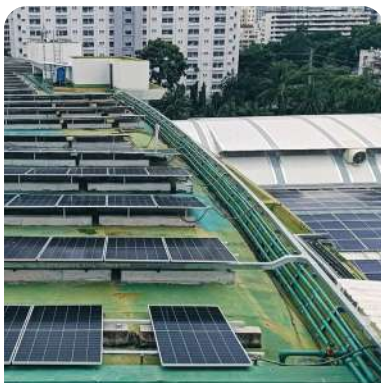
งานติดตั้งท่อ
