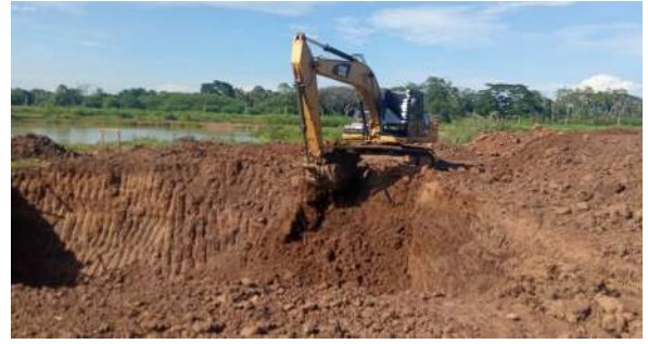
งานจัดเตรียมพื้นที่หน้างานและขุดบ่อพักน้ำ
