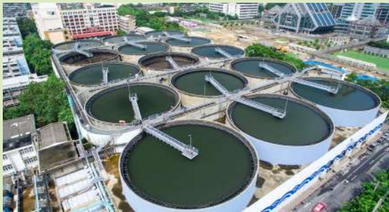
ถังตกตะกอน หรือถังพักน้ำ
