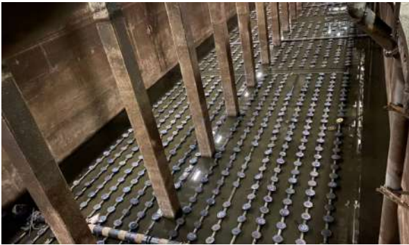
งานจัดหาและติดตั้งหัวจ่ายระบบอากาศ ในบ่อเติมอากาศ
