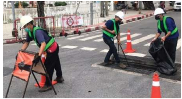
การตรวจสอบระบบท่อรวบรวมและกำจัดขยะภายในบ่อ
