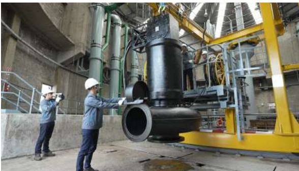
งานจัดหาและติดตั้งเครื่องสูบน้ำเสีย
