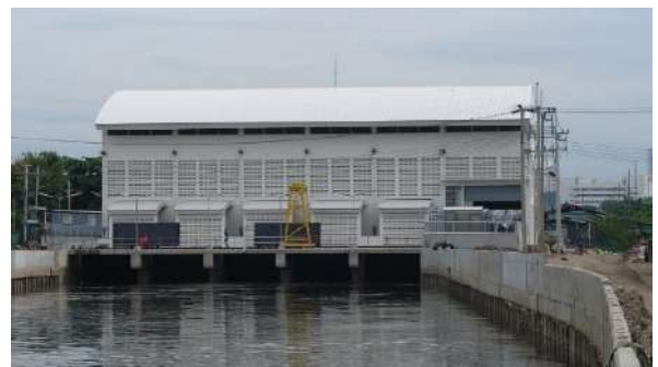
สถานีสูบน้ำคลองขุดวัดช่องลม
