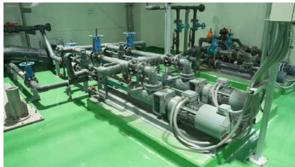
งานจัดหาและติดตั้งเครื่องสูบน้ำ
