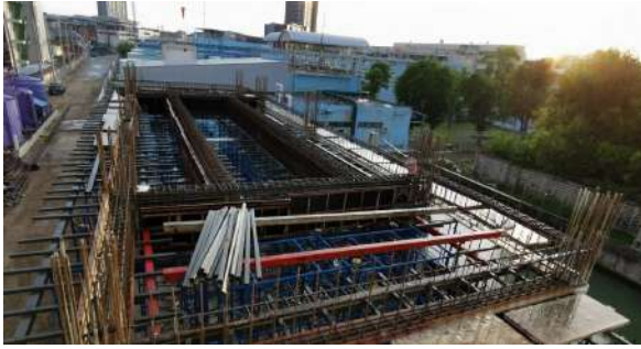
งานก่อสร้างอาคารระบบกำจัดตะกอน
