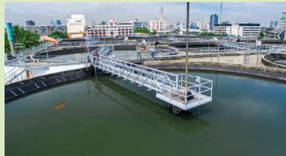
ถังตกตะกอน หรือถังพักน้ำ
