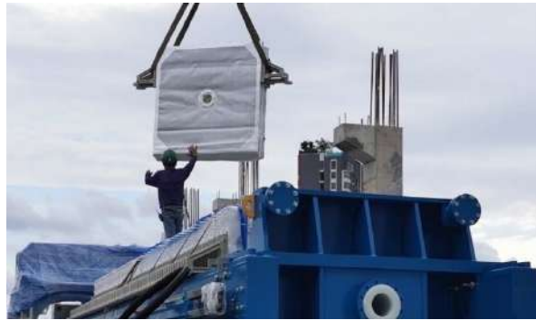
งานติดตั้งระบบกำจัดตะกอน
